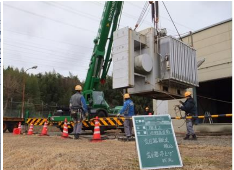
取組③ 積込作業時の積載物重量の確認(吊上げ時、クレーン操作室に表示される吊荷の重量を確認します)
