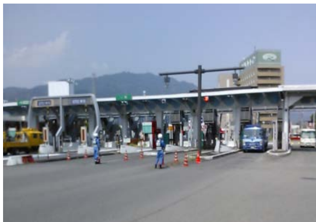
高速道路料金所での引き込みの状況
