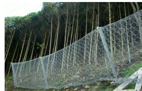
高エネルギー吸収型落石防護柵
