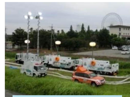
排水ポンプ車による排水訓練
