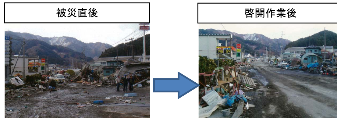
道路啓開の状況(出典:東北地方整備局道路部 東日本大震災対応記録誌)
