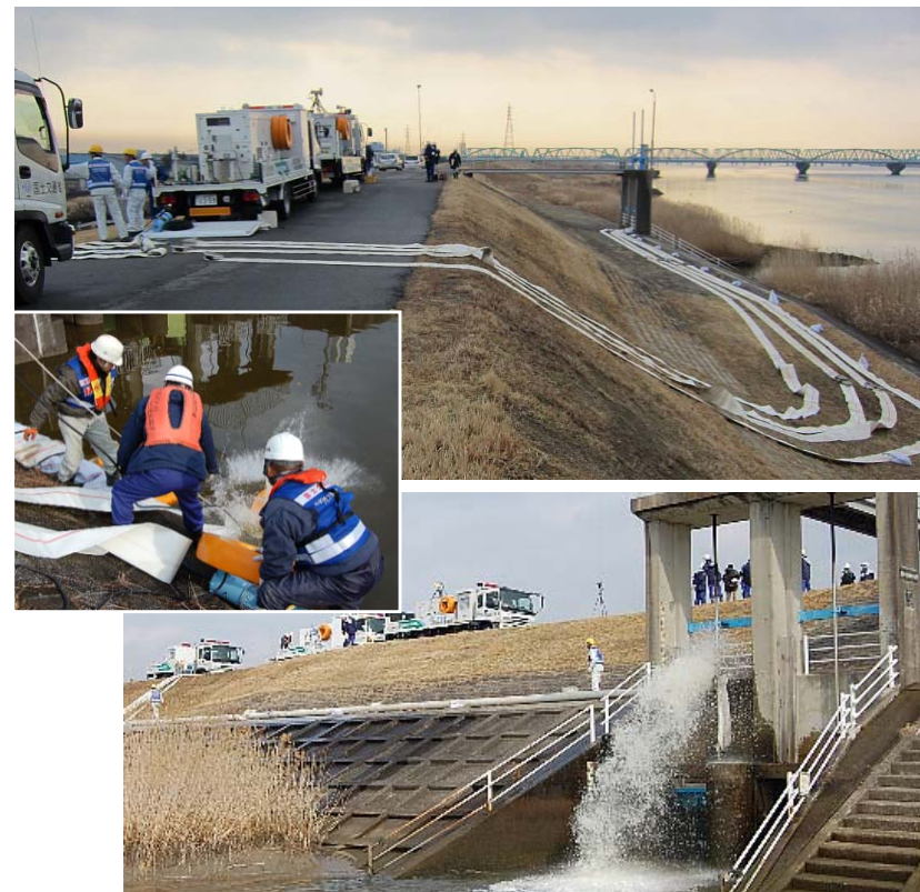
【濃尾平野(佐屋川排水機場付近:愛知県)】
