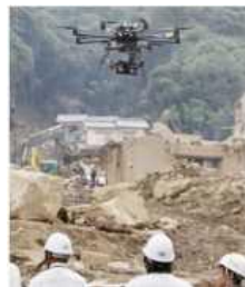
ドローンによる調査状況
