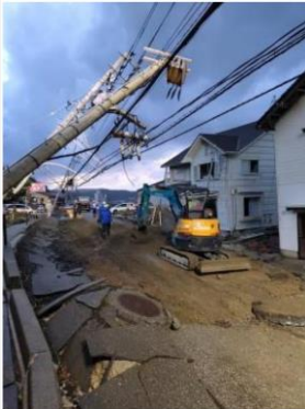
石川県輪島市国道249号
