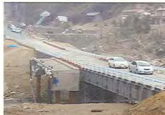
▲応急復旧後（4月4日15時開放）
