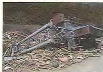
▲情報板倒壊 宮城県南三陸町
