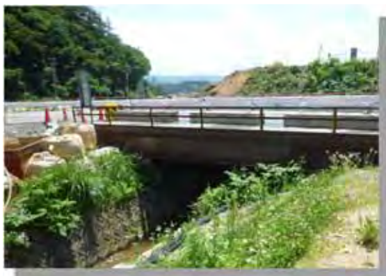
仮橋設置の例
