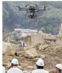
ドローンによる調査状況
