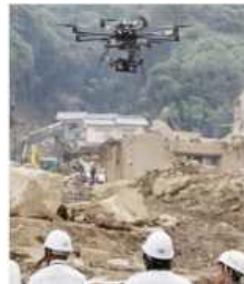
ドローンによる調査状況
