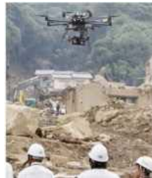
ドローンによる調査況
