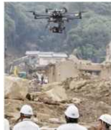
ドローンによる調査況
