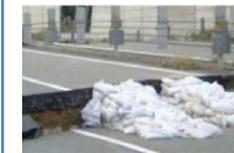
橋上部に段差が生じた箇所は、土のうによる段差のすり付けを想定する。
