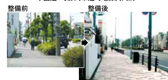
◇国道1号静岡市辻町電線共同溝
