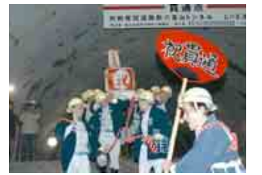
貫通した熊野尾鷲道路新八鬼山トンネル(尾鷲市)
