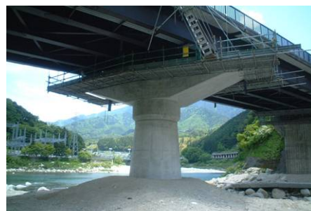
橋脚の耐震補強の一例
