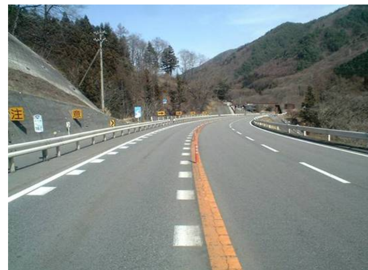
◇ポストコーンによる追い越し防止対策例
