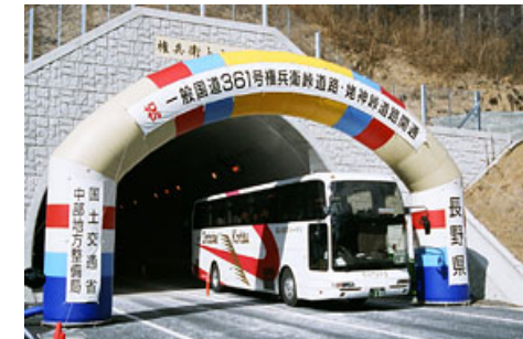
◇平成18年2月に開通した権兵衛峠道路
