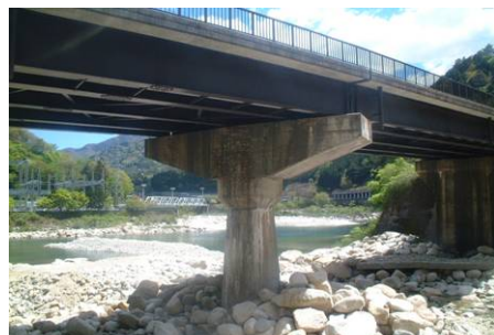
橋脚の耐震補強の一例
