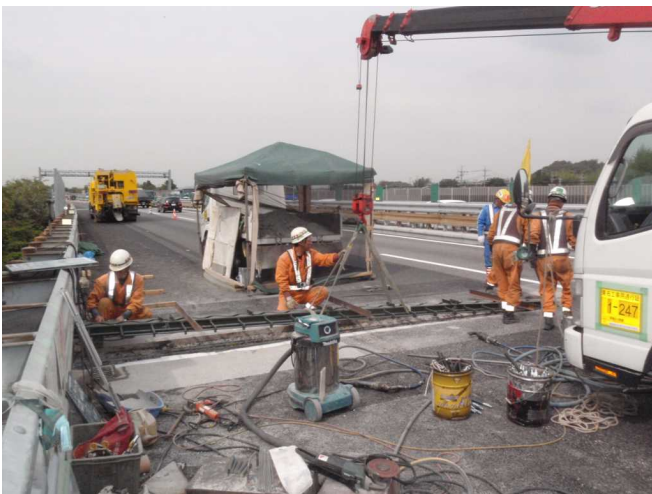
〔伸縮装置の取り替え〕
