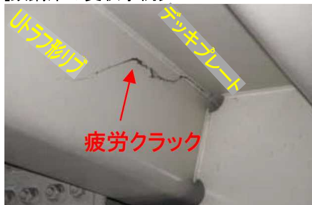
出典：高速道路資産の変状状況(高速道路資産の長期保全及び更新のあり方 中間とりまとめ 平成25年4月25日：高速道路資産の長期保全及び更新のあり方に関する技術検討委員会)
