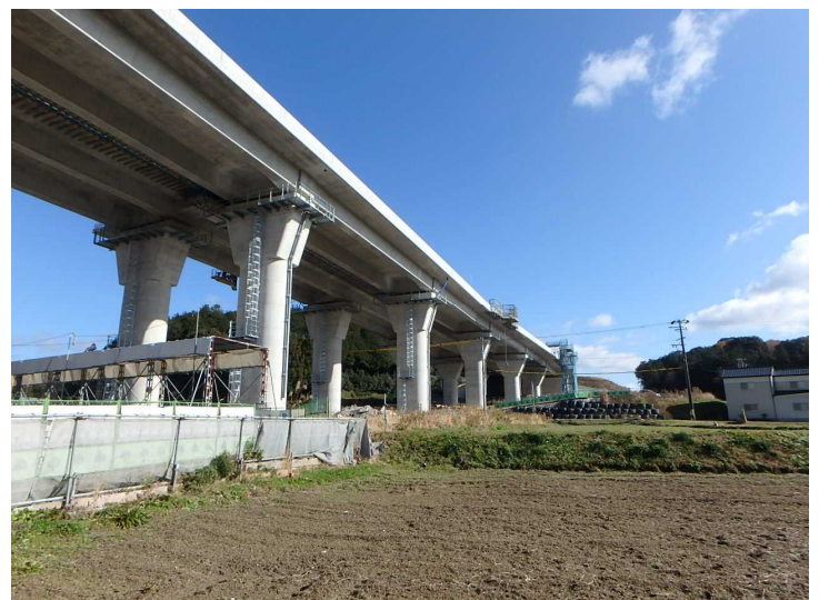
新城IC付近 五反田川高架橋
