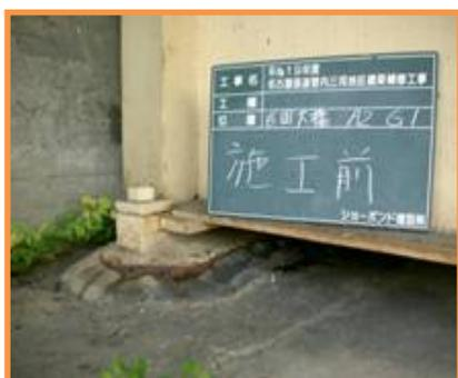
【補修前（支承の腐食）】
