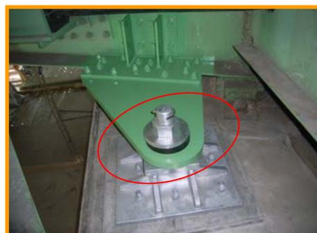
対策後（支承部の補強（変位制限装置））
