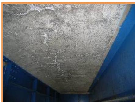
【補修前（床版コンクリートひびわれ）】
