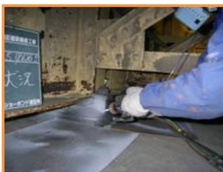
【補修状況（支承防錆処理）】
