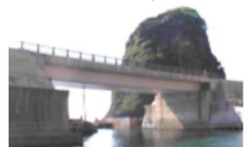
海からの塩分により、コンクリートがはがれ落ちたところ
