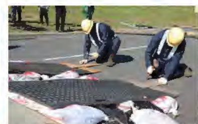
土のうを積み上げるなどにより道路の段差をなくす
