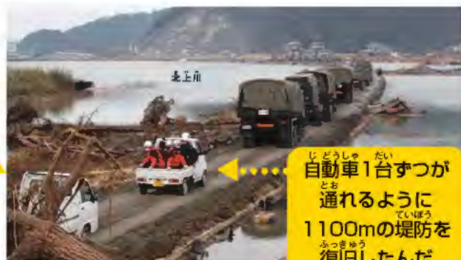
堤防の応急復旧により通行可能に
