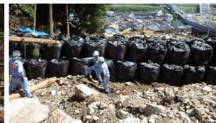
大型土のう設置箇所の確認(9月7日撮影)
