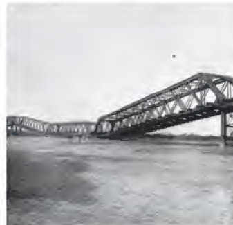
東海道線長良川鉄橋 (現・岐阜県岐阜市一瑞穂市)
