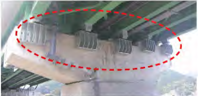
橋の下に支えをつくり、橋を落ちにくくする
