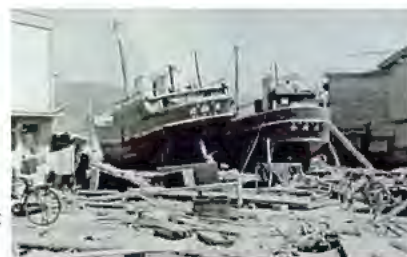
津波で打ち上げられた 漁船(三重県尾鷲港)
