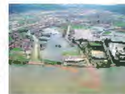
諏訪湖周辺の浸水状況
