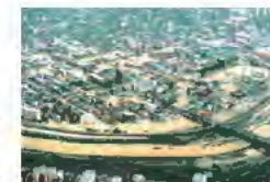
名古屋市天白区平子橋付近の 浸水状況
