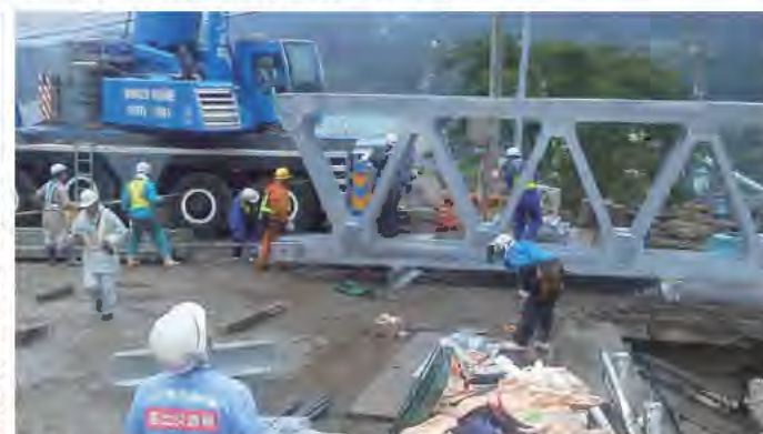
橋梁架設班による県道梨子沢橋の仮橋の架設(7月13日撮影)
