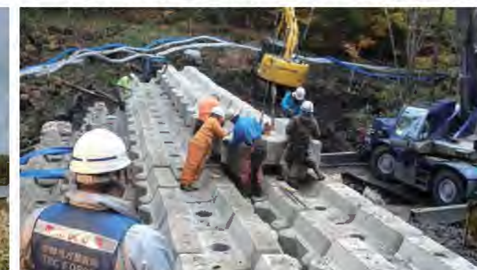
鹿ノ瀬川の砂防えん堤設置工事(10月22日撮影)
