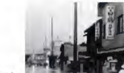
三重県伊勢市の浸水状況
