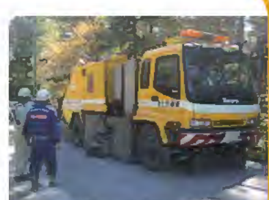
道路の火山灰を取りのぞく 中部地方整備局の作業車
