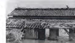
岐阜県養老町の浸水状況
