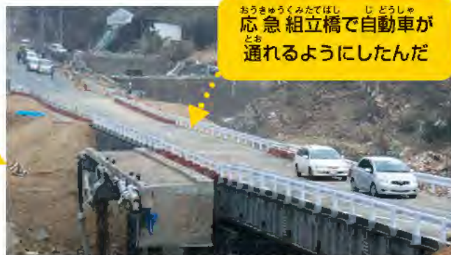
仮の応急組立橋をつかって通行可能に
