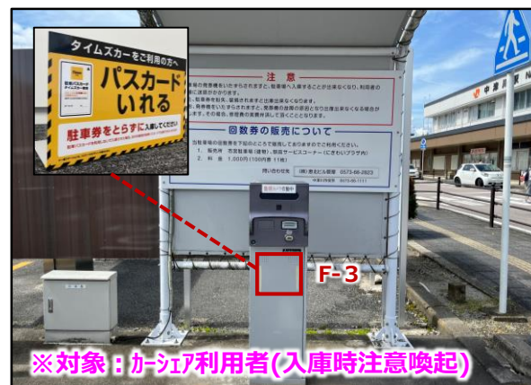
F-3：発行機の下部へ注意喚起シール貼付け
