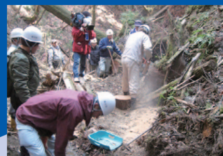
櫃坂道古坂の復旧の様子
