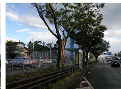
台風時の倒木事例 (国道1号 愛知県豊橋市)
