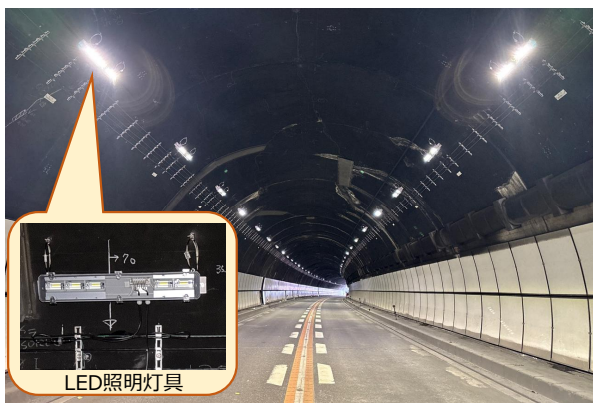
整備事例：国道1号 潮トンネル（静岡県藤枝市）
