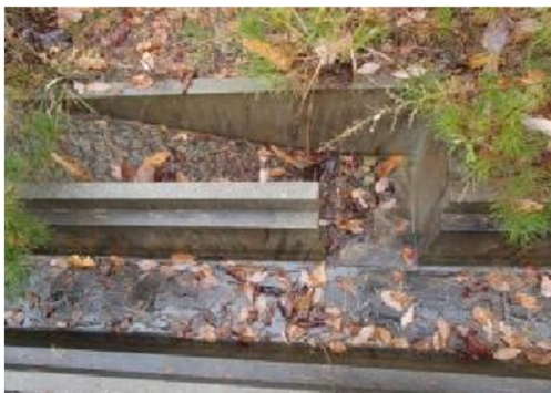
カエルなどの両生類が水路に落ちてもしい上がれるような坂路をつけた水路を設置しました。
