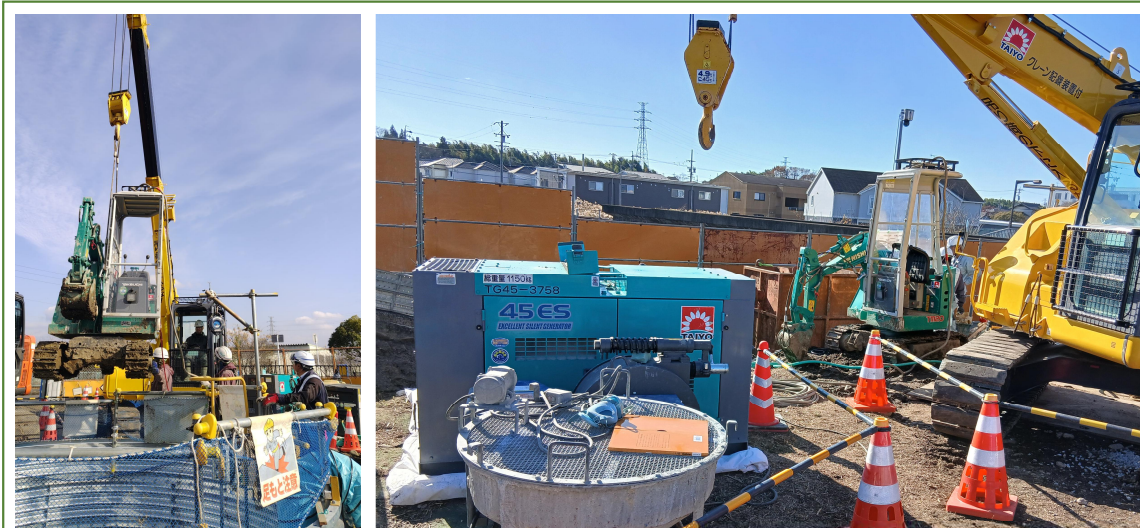
R7現場試行状況(有線式)
