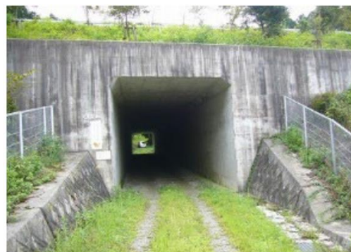
土砂敷舗装のボックスカルバートを設置して、シカやタヌキなどの移動経路を確保しました。
