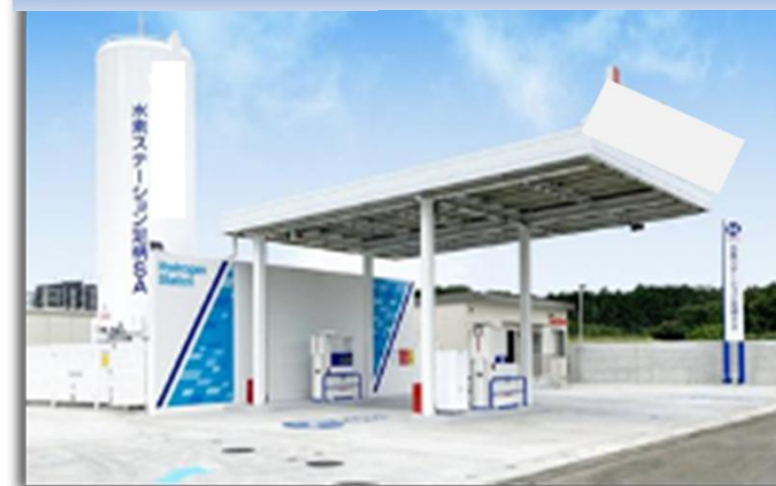
水素供給施設
