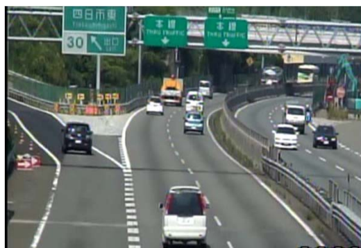
【付加車線設置前】
