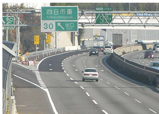
【付加車線設置後】
