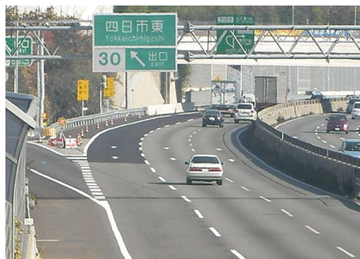
【付加車線設置後】
