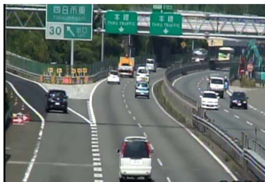
【付加車線設置前】
