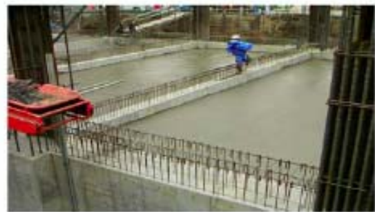
【写-2 流動化処理土打設完了状況】
