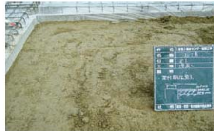
再生処理土 埋戻土に使用
