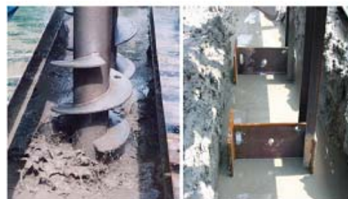
高流動化技術の施工状況
