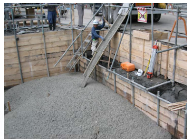
実施における打設状況
