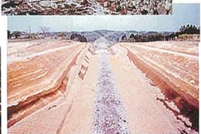
工事用道路の状況
