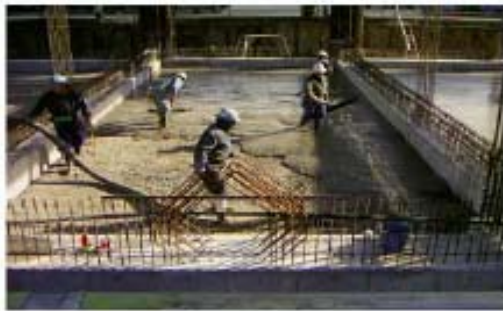
【写-1 流動化処理土打設状況】
