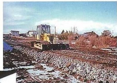
スラグの敷均し
