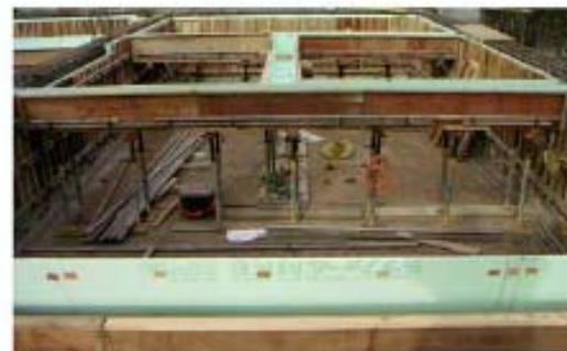
【写-4 土間コン後の床スラブ支保工状況】
