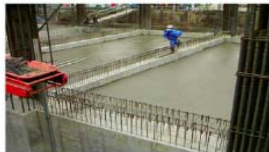
【写-2 流動化処理土打設完了状況】
