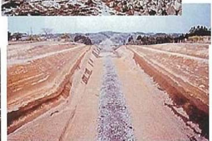
工事用道路の状況
