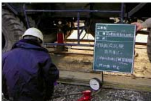
【写-3 載荷試験状況】
