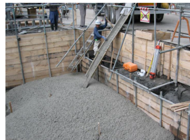
実施における打設状況
