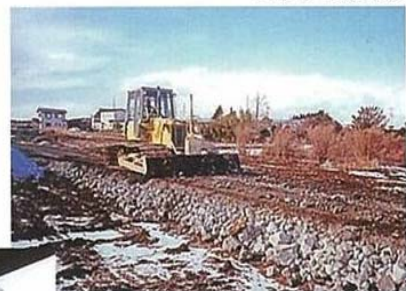
スラグの敷均し
