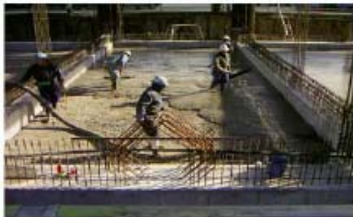
【写-1 流動化処理土打設状況】
