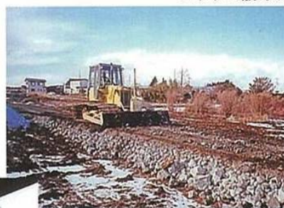
スラグの敷均し
