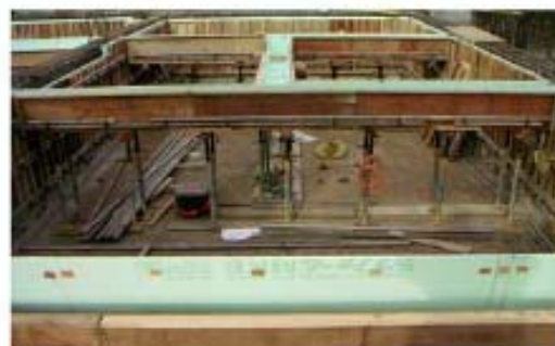
[写-4 土間コン後の床スラブ支保工状況]
