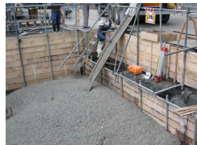
実施における打設状況
