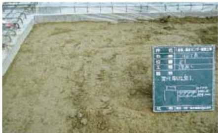
再生処理土 埋戻土に使用
