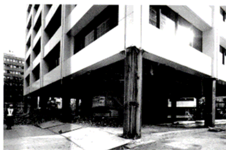
ジャッキダウンで解体が進む
