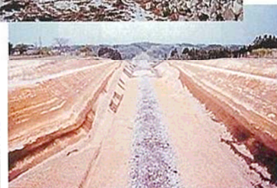
工事用道路の状況
