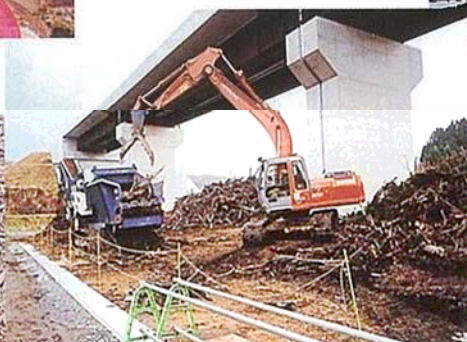
自走式破碎機への投入
