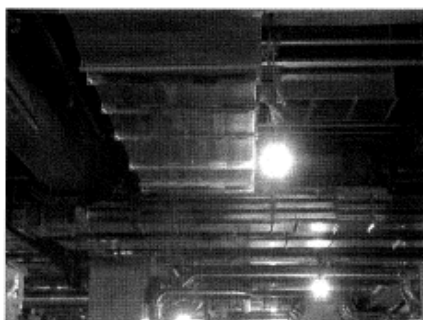
給排気ダクトの原寸取り工場加工
