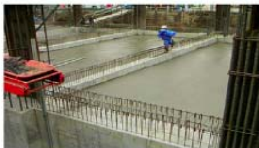
[写-2 流動化処理土打設完了状況]
