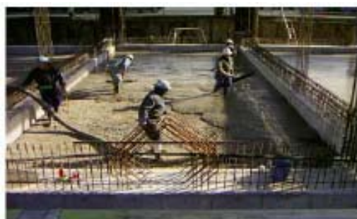
[写-1 流動化処理土打設状況]
