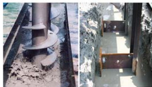
高流動化技術の施工状況
