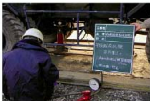
[写-3 載荷試験状況]
