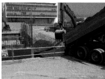
杭汚泥の「自ら利用」
