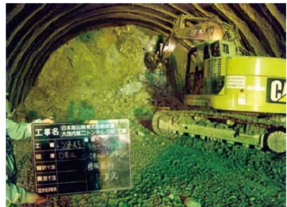
大型ブレーカーによる追加掘削
