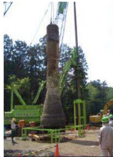
写真-1 掘り出した杭状況
