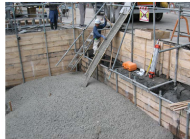
実施工における打設状況
