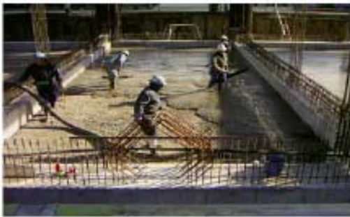
【写-1 流動化処理土打設状況】
