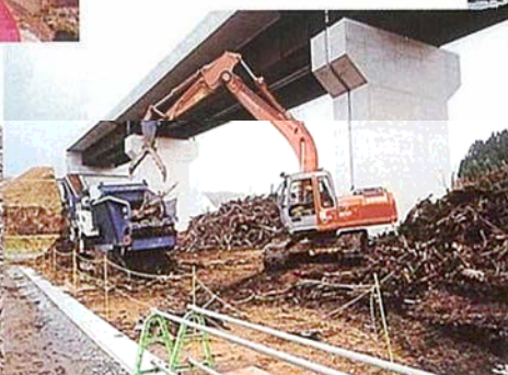
自走式破砕機への投入
