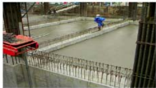
【写-2 流動化処理土打設完了状況】
