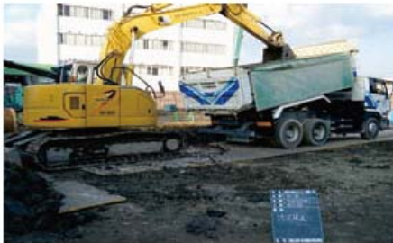
発生土の処理（リサイクルプラントへ搬出）
