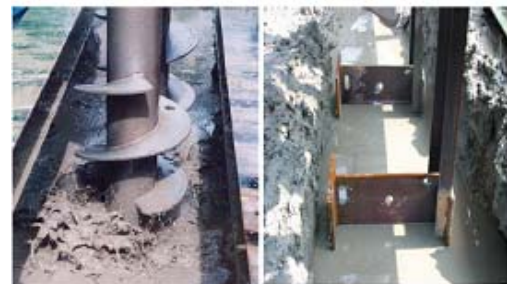
高流動化技術の施工状況
