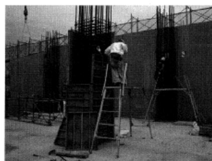
柱型枠に特注寸法パネルを使用
