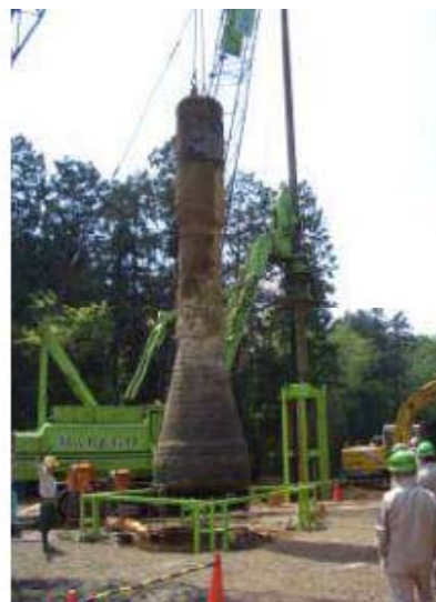
写真-1 掘り出した杭状況
