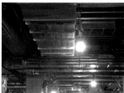
給排気ダクトの原寸取り工場加工
