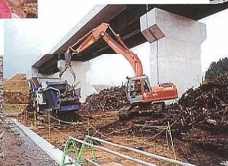
自走式破碎機への投入
