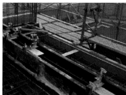
床立上り躯体に鋼製型枠を使用
