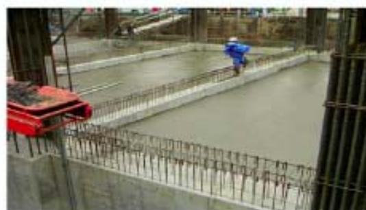
[写-2 流動化処理土打設完了状況]
