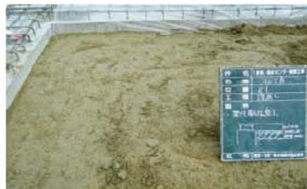
再生処理土 埋戻土に使用
