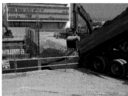
杭汚泥の「自ら利用」
