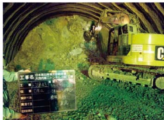
大型ブレイカーによる追加掘削
