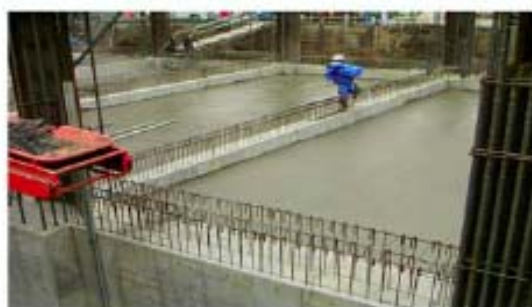
[写-2 流動化処理土打設完了状況]
