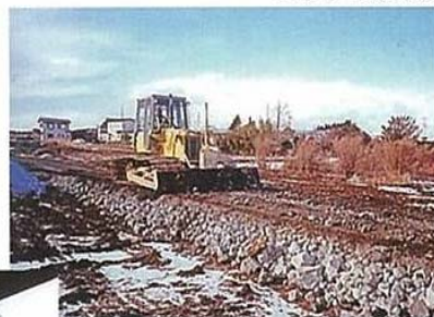
スラグの敷均し
