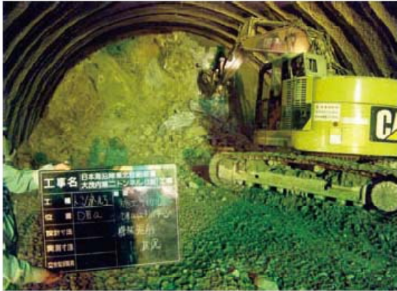
大型ブレーカーによる追加掘削
