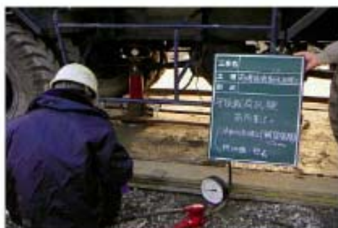
[写-3 載荷試験状況]
