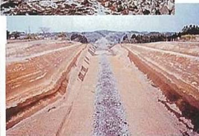
工事用道路の状況
