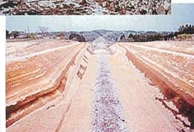
工事用道路の状況
