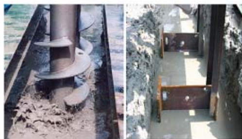
高流動化技術の施工状況
