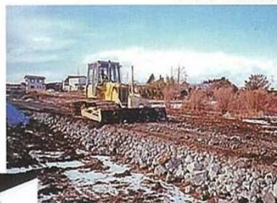
スラグの敷均し
