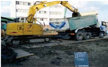
発生土の処理（リサイクルプラントへ搬出）
