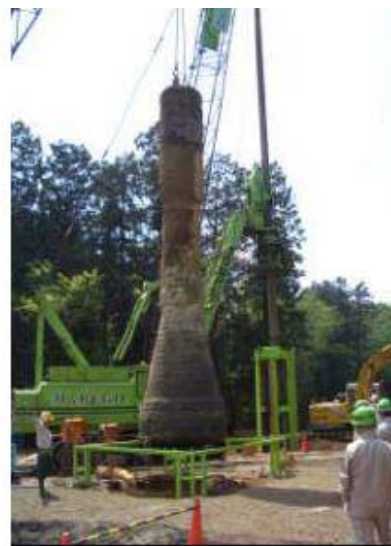
写真-1 掘り出した杭状況
