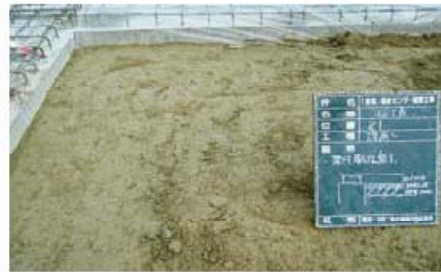
再生処理土 埋戻土に使用
