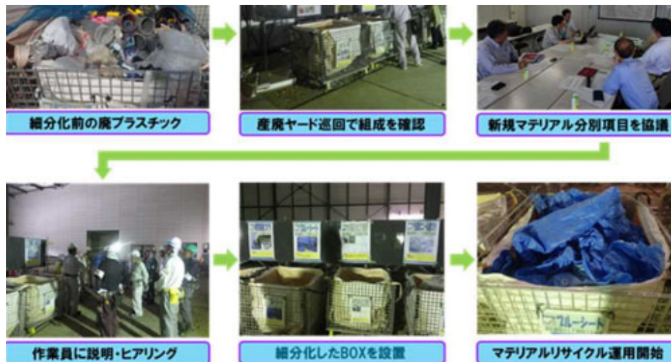
図16 建設現場における廃プラスチックの新規マテリアルリサイクル品目開拓の流れ
