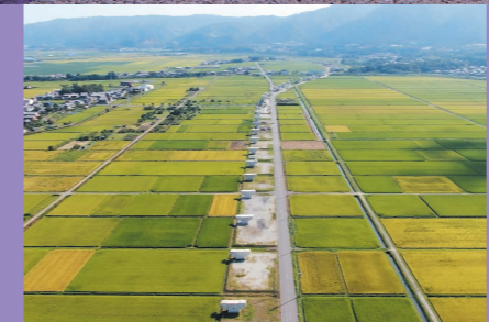
道路が通る予定の岐阜県養老郡養老町を上空から見た様子。現在は橋脚が完成し、これから橋桁の建設作業に着手。
