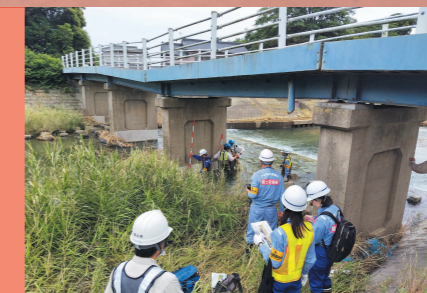
市道の橋脚が大雨で沈下して上部構造に変状が見られた際には、要請に応じて、中部地方整備局の職員が現地に赴き、復旧の技術的助言などを実施。
