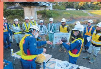
橋梁点検講習会の様子。参加した地方公共団体の職員等に点検支援技術の実演や橋梁補修DIYについて紹介。
