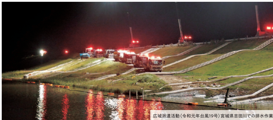
広域派遣活動 (令和元年台風19号) 宮城県吉田川での排水作業
