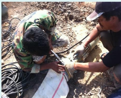
タイ側作業員による設置作業
