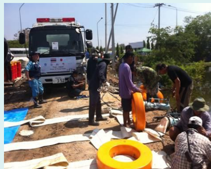
タイ側作業員による設置作業
