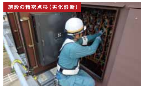
施設の精密点検(劣化診断)
