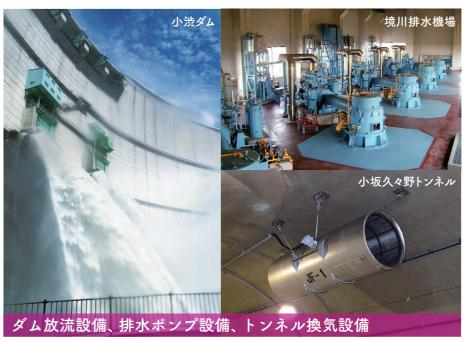
洪水調節や河川環境の保全のためにダムから水を放流するダム用水門設備、私たちの住んでいる街に水が溢れないように内水を排除する排水ポンプ設備、車両の排気ガスをトンネル外に流すトンネル換気設備(ジェットファン)など、様々な機械設備を整備しており、定期的に整備を行うことで、いつでも動かせるよう、万全の状態に管理しています。
