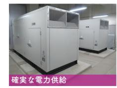
予備電源設備により、停電時においても情報通信設備等に電力を確実に供給します。
