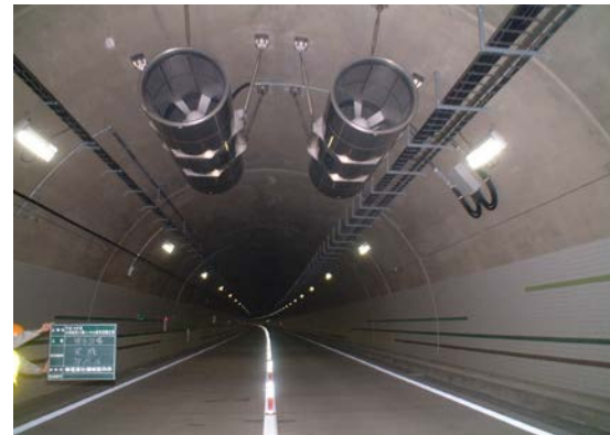
トンネル換気設備(ジェットファン)
