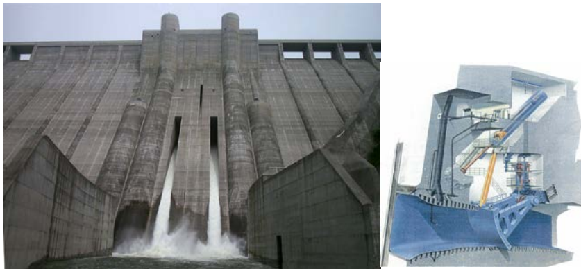
ダム放流設備(ゲート)
