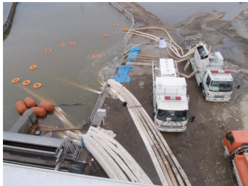
福島県相馬市における排水状況
