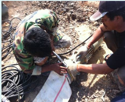
タイ側作業員による設置作業
