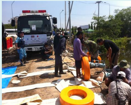
タイ側作業員による設置作業
