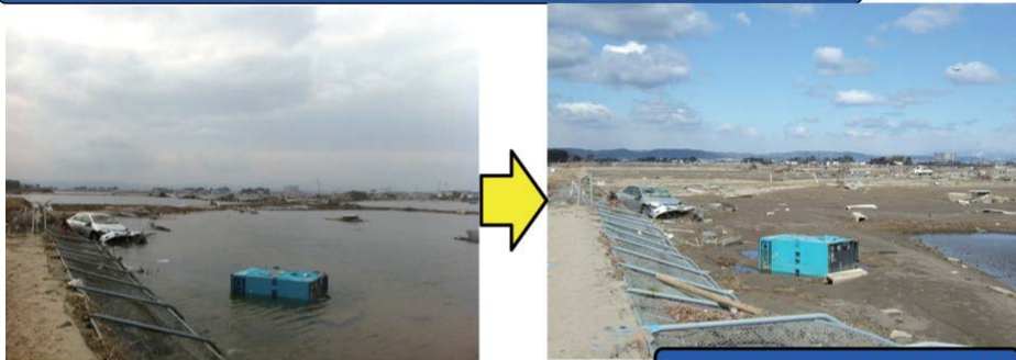
●宮城県仙台空港付近
