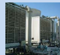
空調室外機 (屋上)
