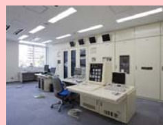
中央監視装置 (管理室)
