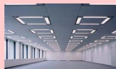
照明設備 (事務室)
