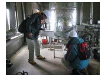
公共施設の被災状況調査
