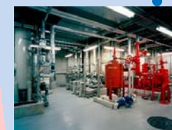
熱源機器・ポンプ (機械室)
