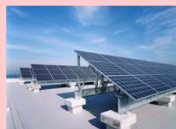
太陽光発電設備 (屋上)
