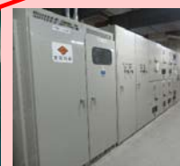
受変電設備 (電気室)
