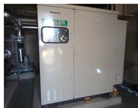
空調設備機器
