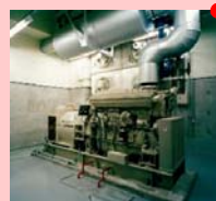
自家発電設備 (自家発電室)
