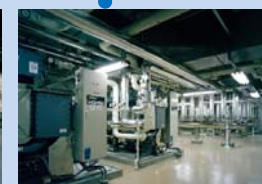
実験用設備(機械室)
