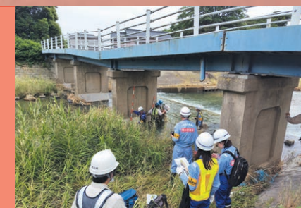
市道の橋脚が大雨で沈下して上部構造に変状が見られた際には、要請に応じて、中部地方整備局の職員が現地に赴き、復旧の技術的助言などを実施。
