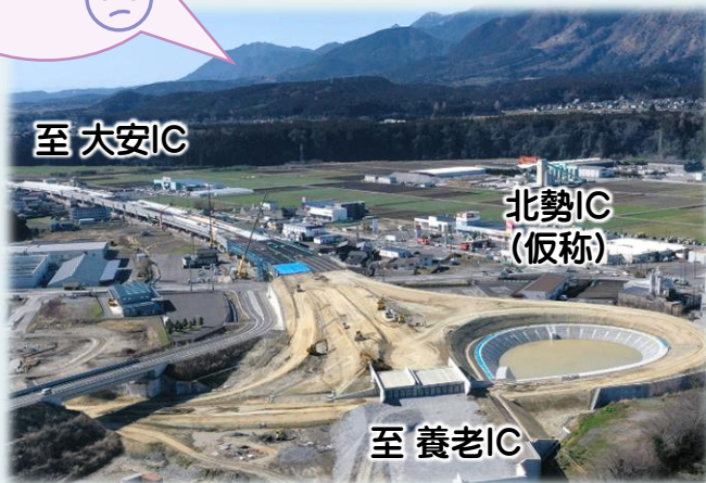
国道475号東海環状自動車道
