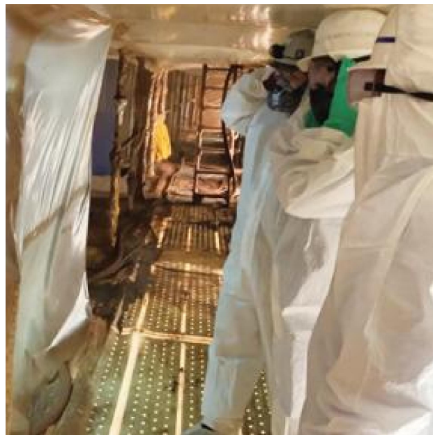
大堀平洞門にてプラスト作業を見学する様子
