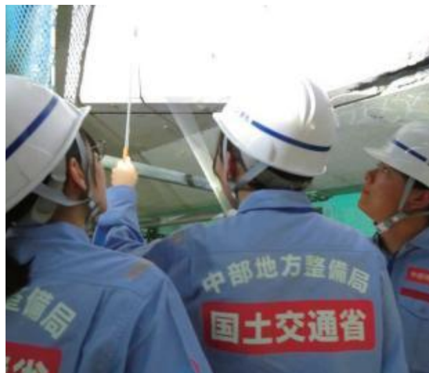
実現場で損傷状況を把握
