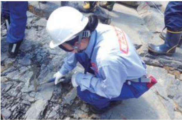
高さ120メートル級の巨大な重力式コンクリートダムを支える基礎岩盤の国土交通省職員による検査に臨場
