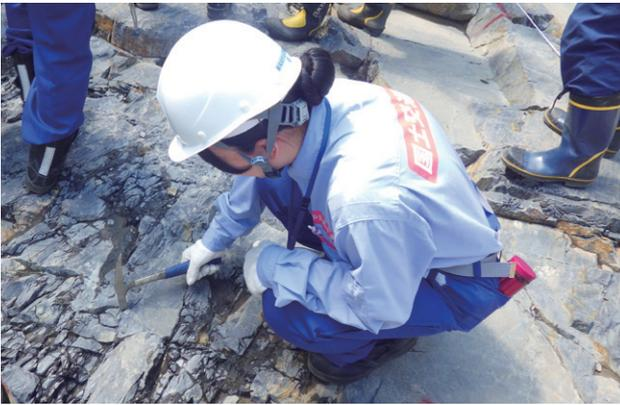
高さ120メートル級の巨大な重力式コンクリートダムを支える基礎岩盤の国土交通省職員による検査に臨場
