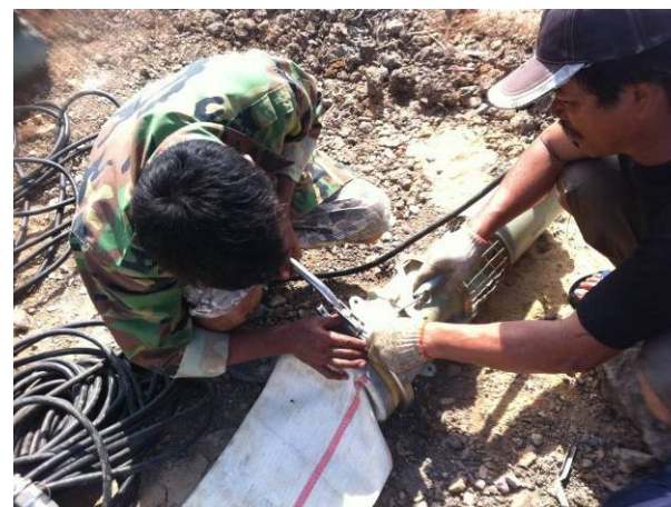
タイ側作業員による設置状況
