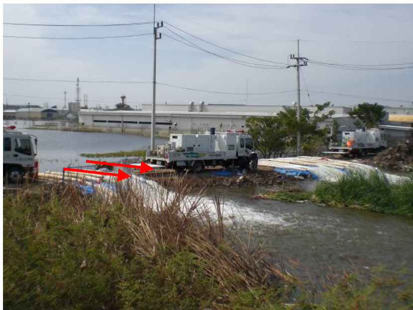
排水状況(全体)
