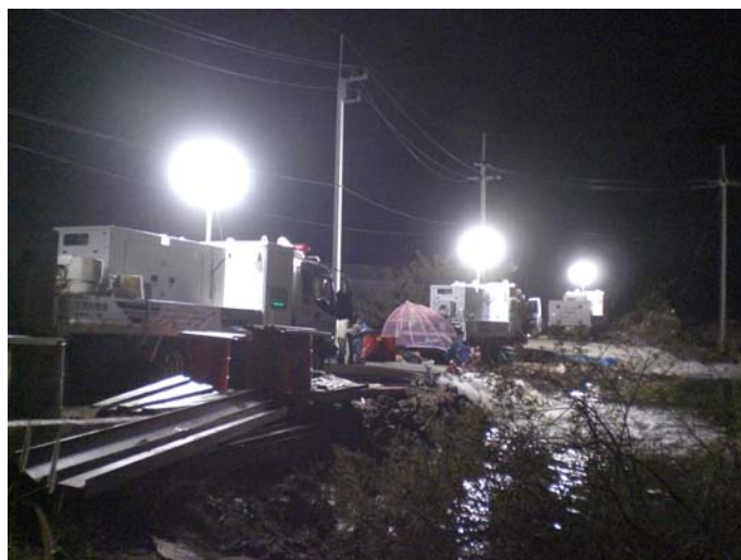
24時間体制の排水作業
