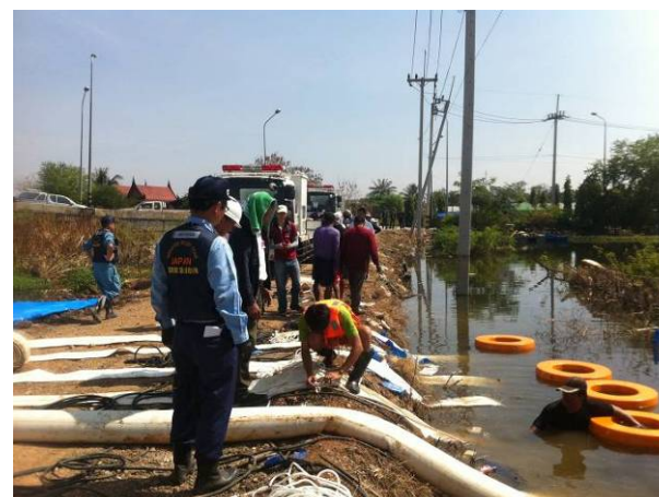
タイ側作業員による設置状況
