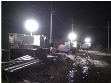
24時間体制の排水作業
