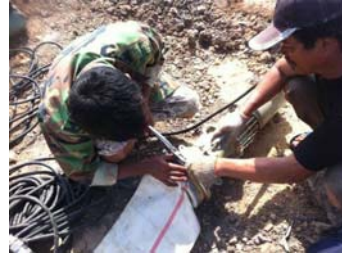
タイ側作業員による設置状況
