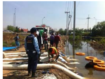
タイ側作業員による設置状況
