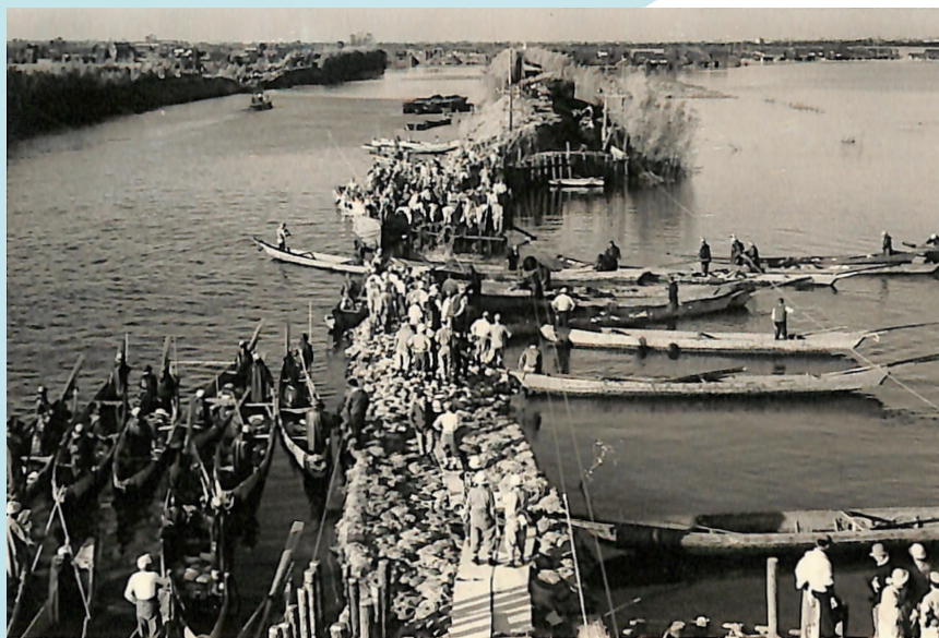
堤防決壊した日光川水系東小川左岸の仮締切工事（名古屋土木局撮影、名古屋大学所蔵）
