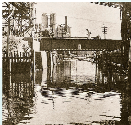
伊勢湾台風により被災した金川製造所 ・ 港明製造所（東邦ガス提供）
