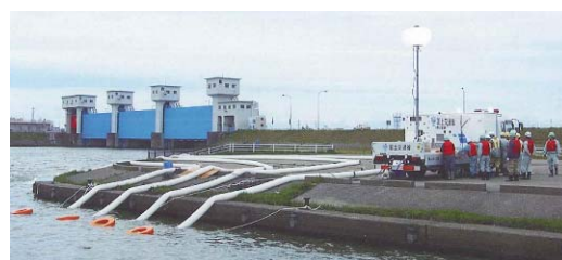
排水ポンプ車の稼働光景(イメージ)
