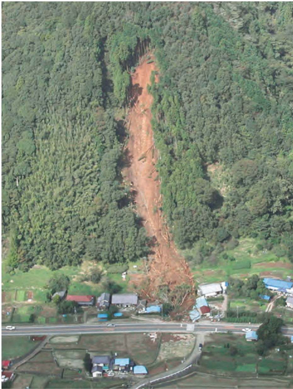
H16 台風22号被害（国道136号沿い・上船原）
