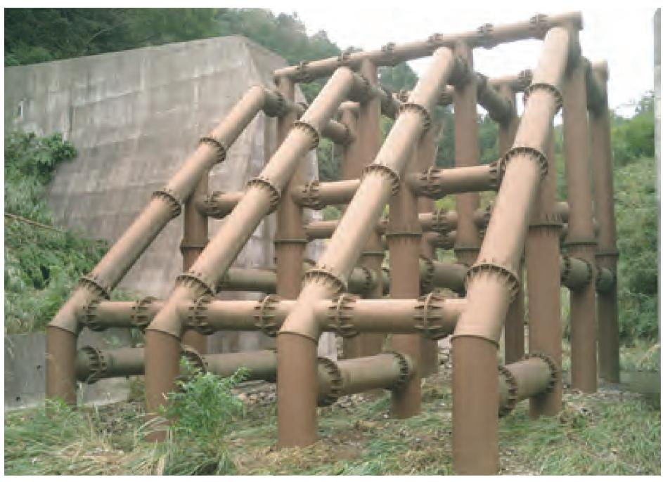
アザミ川第2砂防堰堤は、真ん中が丈夫な鉄鋼製のジャングルジムのような格子でできた砂防堰堤です。特に大きな土石流が発生した時に、活躍します。
