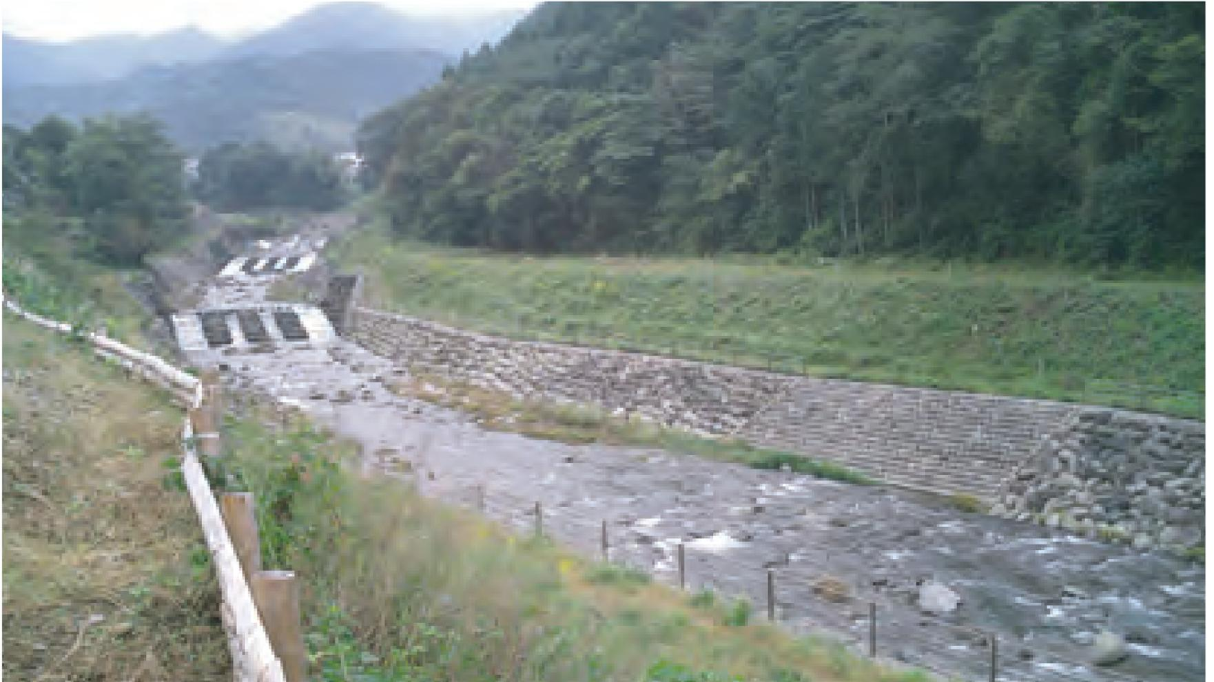
長野床固工群は、川の流れを安定させるために整備されました。コンクリート表面には石を張り、魚に配慮して魚道も造られています。
